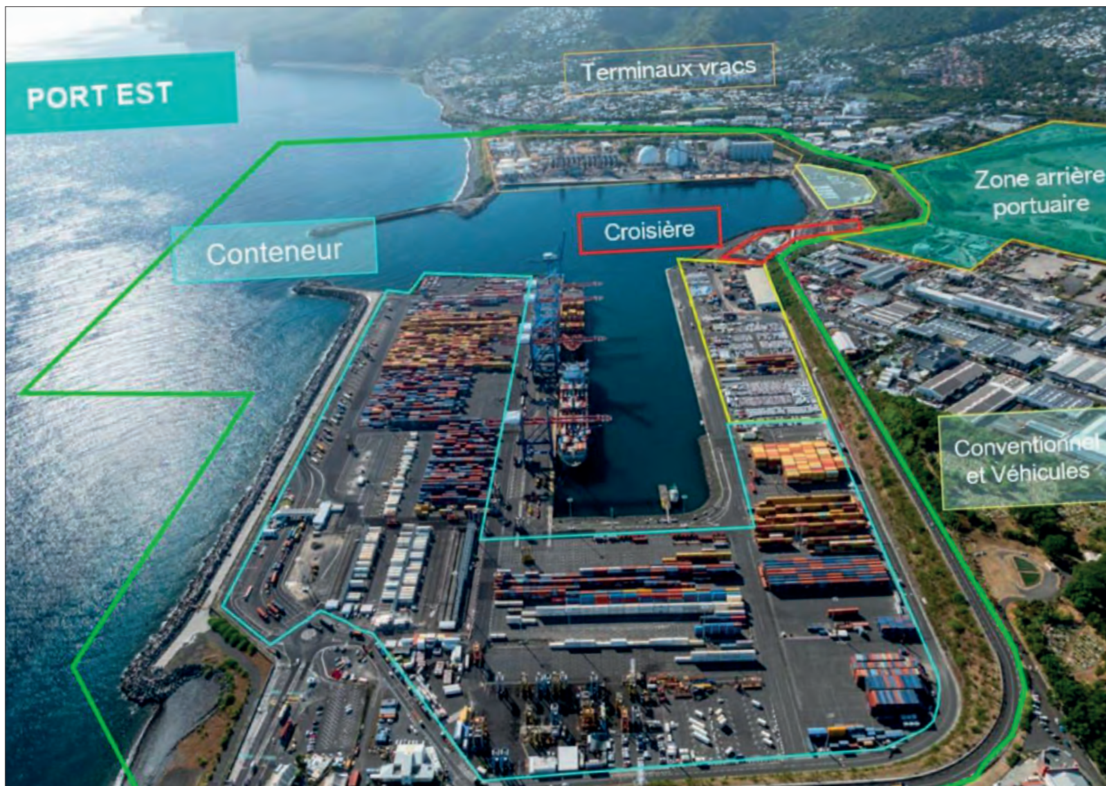
Vue générale du port Est.
