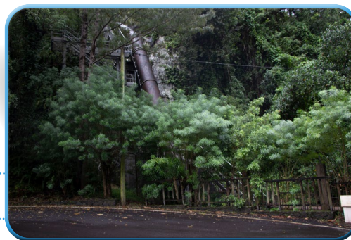
Centrale hydroélectrique EDF
