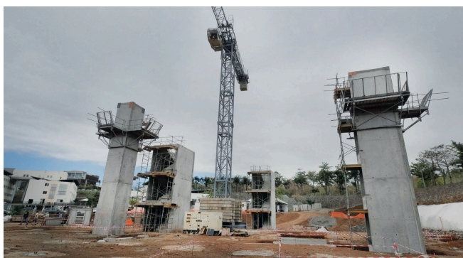
C'est en novembre 2021 qu'est prévue la livraison du chantier. (Photo LYL)
